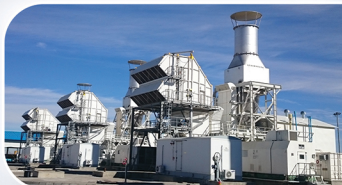
ساخت و نصب ۱۰۰ دستگاه توربور کمپرسور
