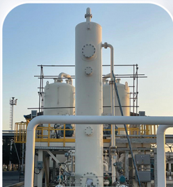
تاسیسات بازیافت بخارات بنزین (VRU) تبریز، اراک، مشهد، اهواز
